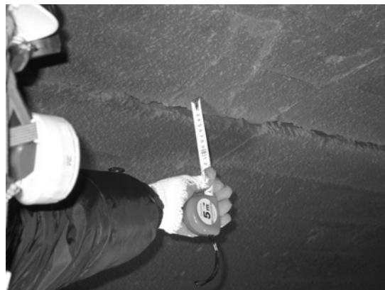
그림 3. 변상이 발견된 지점에서의 종방향 단차균열
