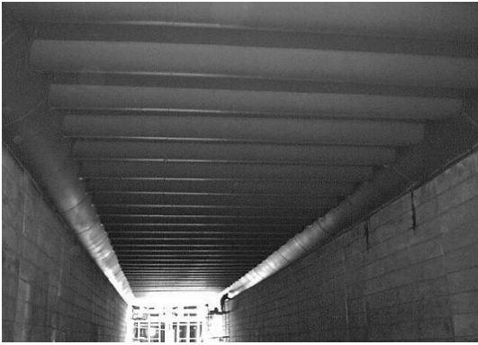
사진 5. 마감 작업 및 T.R.c.M. 공법 완료
