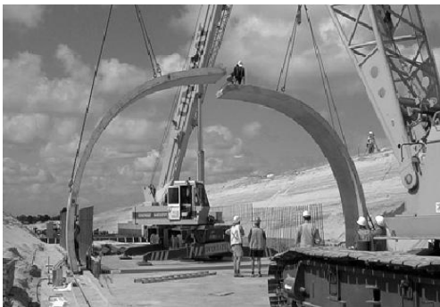
그림 1. 프리캐스트 조립식 터널 시공전경(프랑스)
