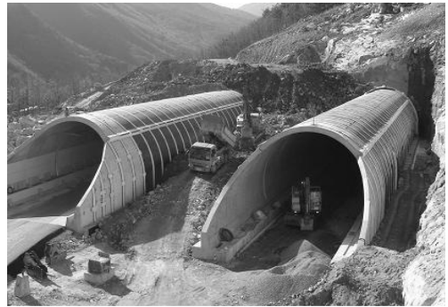
그림 3. 국내 최초 3분절 세그먼트를 이용한 터널구조물
