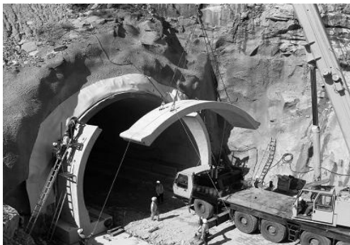
그림 8. 터널 갭문시공을 위한 프리캐스트 세그먼트 조립 전경
