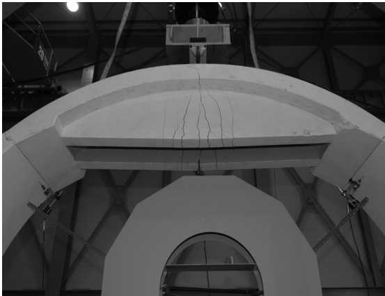
그림 20. A형 리브 보강 프리캐스트 아치세그먼트 파괴 후 전경
