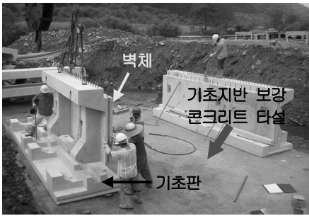
(a) 기초판 설치 및 벽체 조립
