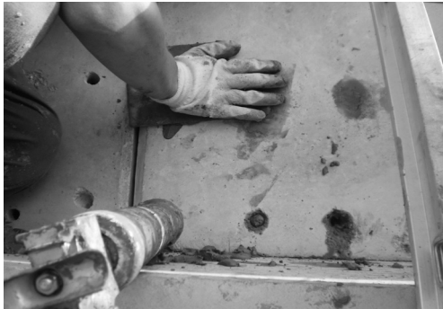
그림 6. 몰타르 충전식 철근이음 그라우팅 전경
