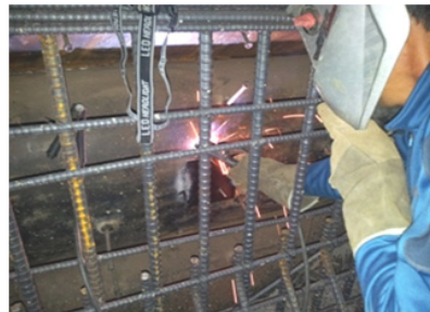
(d) Installation of sensor ④
