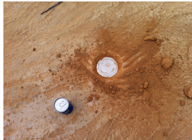
(d) Imbedded sensor② in upper slab
