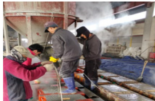
(d) Concrete pouring
