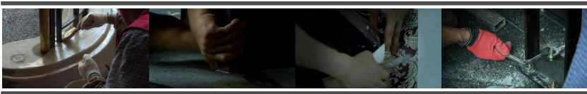
| 그림 1-4 | 서울역사 내부 공사 중인 인부들의 클로즈업 쇼트
