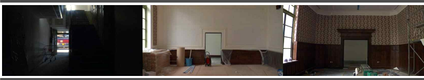
| 그림 1-1 | 복원 공사 중인 서울역사의 내부 공간 모습
